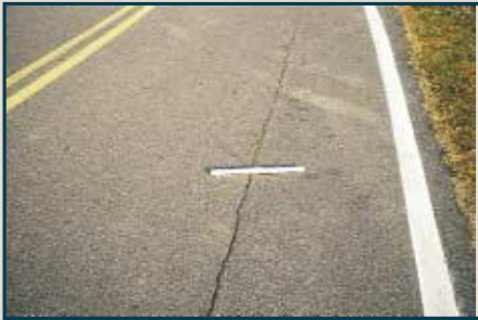
Longitudinal Cracking
